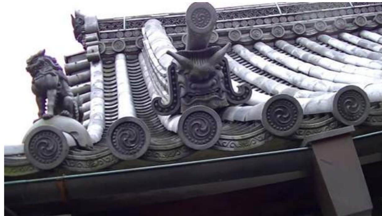
清水寺使用「斗拱」建築技術，防震能力大幅提升，使之能承受多年來的多次地震。
